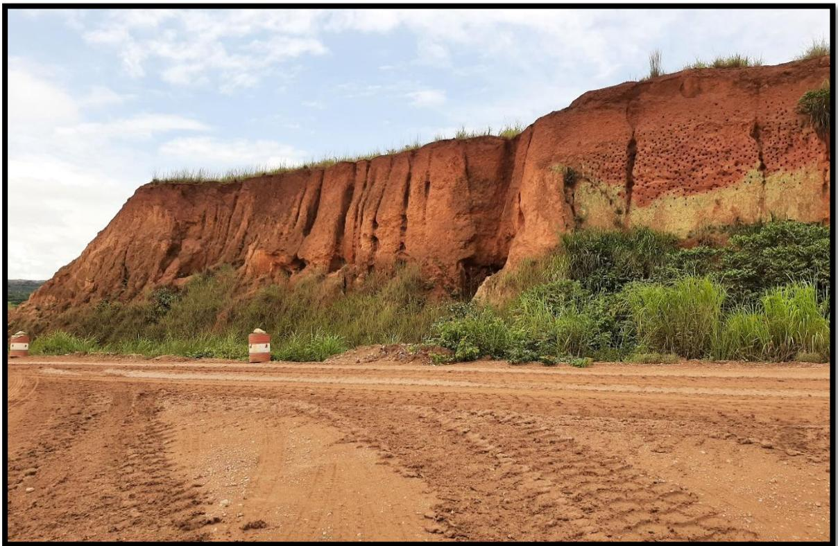
Figura (1) – Erosão nos taludes da formação kalahari.
