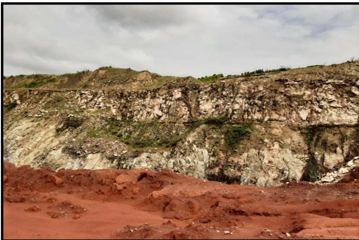
Figura (3) – Taludes formado pelos gnaisses alterados, cobrindo os blocos B1B2B5.
